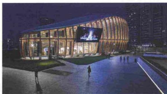
In questa pagina: notturno e sezioni del padiglione con in evidenza le aree funzionali. Il complesso non ha fondazioni: è costruito su un podio in cemento armato che poggia sopra al parcheggio sotterraneo. Una costolatura, in centine verticali e travi in legno lamellare di larice, contiene un involucro di vetro e sostiene una copertura arrotondata di pannelli solari. La struttura si apre all'esterno attraverso due grandi ali dotate di maxischermi per la realizzazione di eventi pubblici
